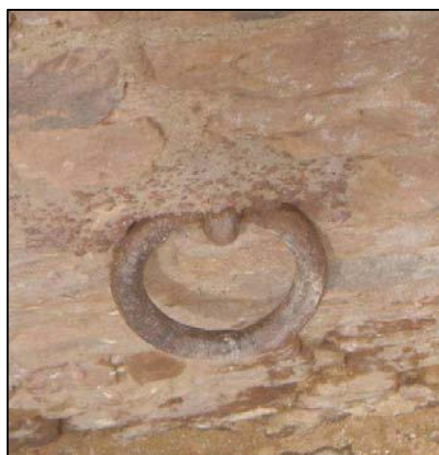
Figure 130 : exemple d'anneau d'amarrage évitant la dégradation des berges par les ancrs
