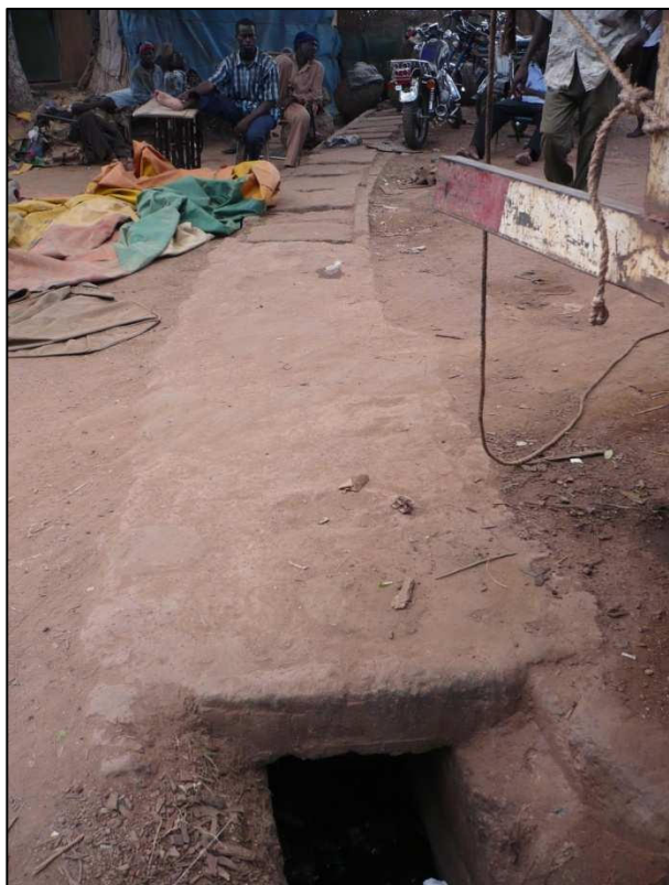
Figure 113 : Caniveaux fermés du port de pêche, source : P. Dhelens, MAK. Diallo, juillet 2008
