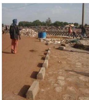
Figure 143 : exemple de Bornes en ciment installé sur le chantier de réhabilitation Source : GAYME S., KONATE D., 2009
